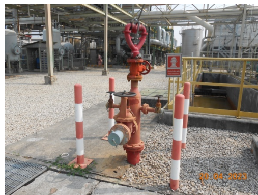
รูปที่ 3.2-34 Fire Hydrant
