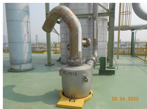
รูปที่ 3.2-4 Cyclone ชุดที่ 1 MC-1512
