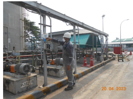
รูปที่ 3.2-44 เจ้าหน้าที่เดินตรวจสอบการรั่วไหล และเหตุการณ์ผิดปกติรอบถังกักเก็บ และแนวท่อขนส่งโมโนเอทิลีนไกลคอล
