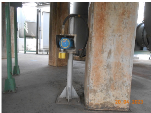
รูปที่ 3.2-31 Gas Detector
