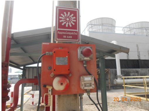
รูปที่ 3.2-35 Fire Alarm
