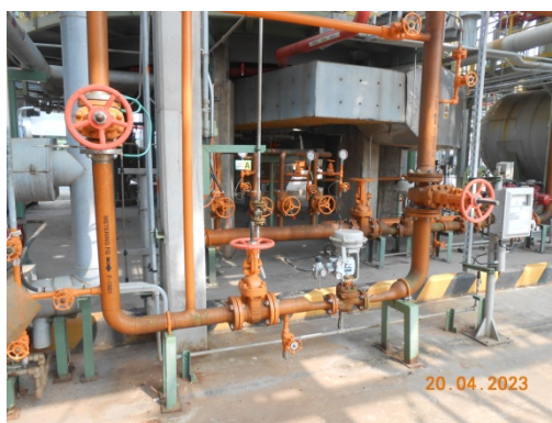
รูปที่ 3.2-49 วาล์วตัดแยกระบบท่อนส่ง ก๊าซธรรมชาติ
