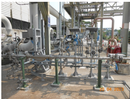
รูปที่ 3.2-45 Pressure Relief Valve
