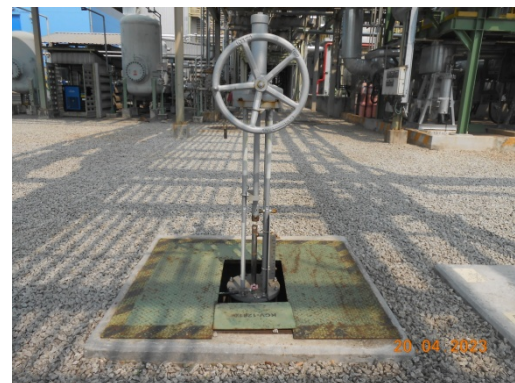
รูปที่ 3.2-16 วาล์วตัดแยกระบบบำบัดน้ำเสีย
