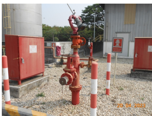
รูปที่ 3.2-50 Fire Hydrant บริเวณท่อนส่งก๊าซธรรมชาติ
