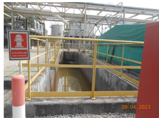
รูปที่ 3.2-10 Oil Separator
