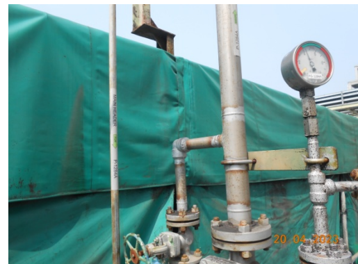
รูปที่ 3.2-14 ระบบ Pressure Gauge
