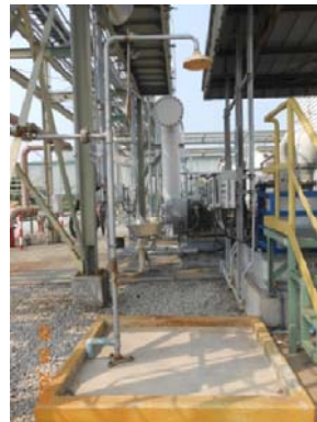
รูปที่ 3.2-30 ฝักบัวและอ่างล้างตาฉุกเฉิน
